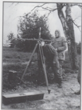
Streckenmessung mit 2m Basislatte
